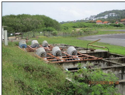
ภาพถ่ายที่ 2.2-38 เครื่องสูบน้ำพญานาค
