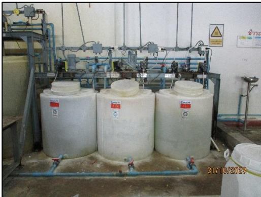
ภาพถ่ายที่ 2.2-36 ถังเติมคลอรีนฆ่าเชื้อโรค
